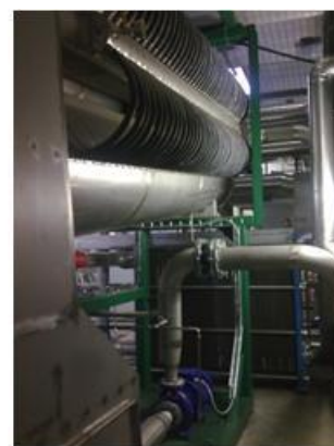
Rökgaskondensatorer med tillhörande VVX. Uppsamlingskärl syns i förgrunden
